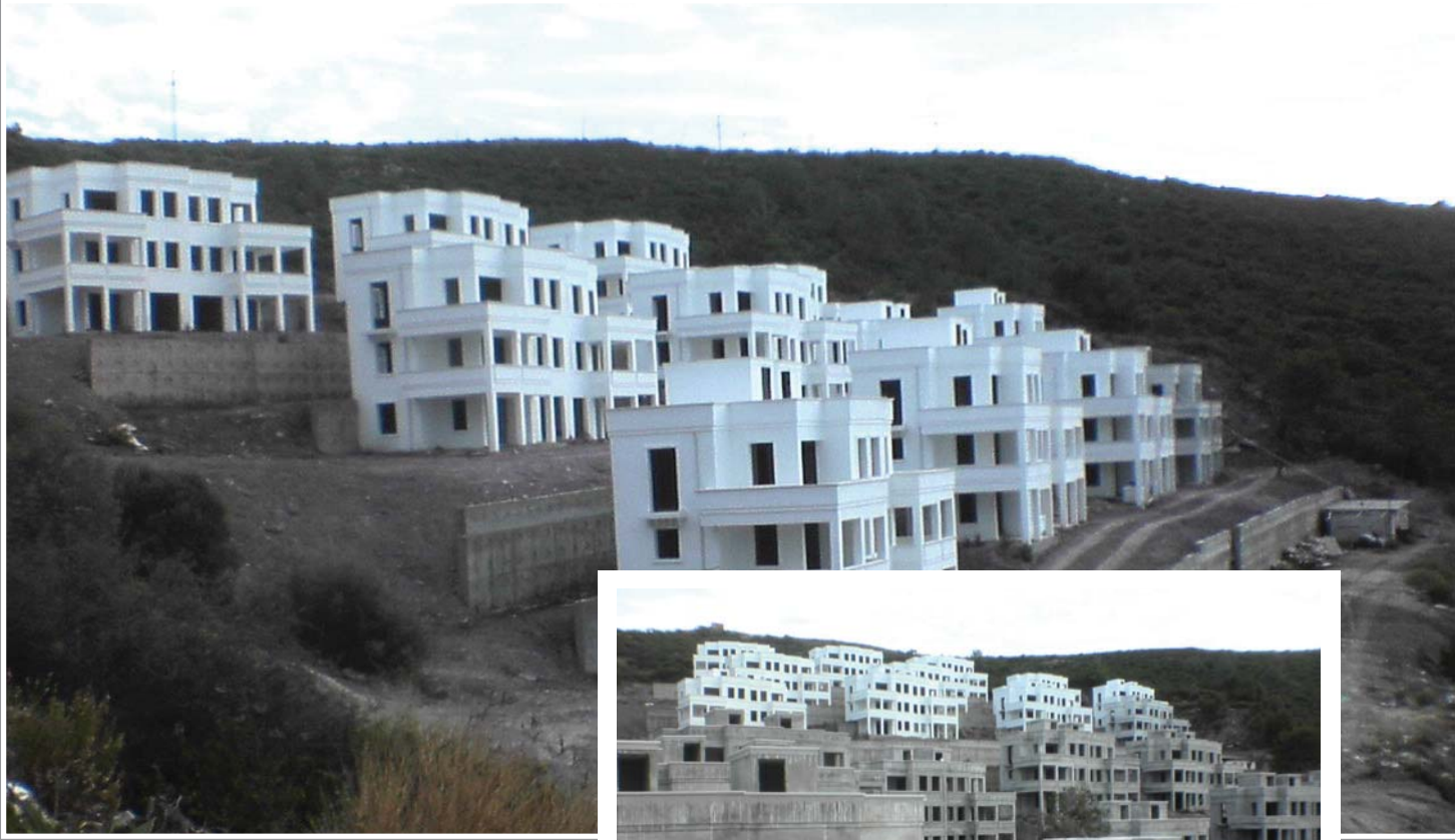
Güvercinlik'te 66 adet 3 katlı villa İnşaâtı.
