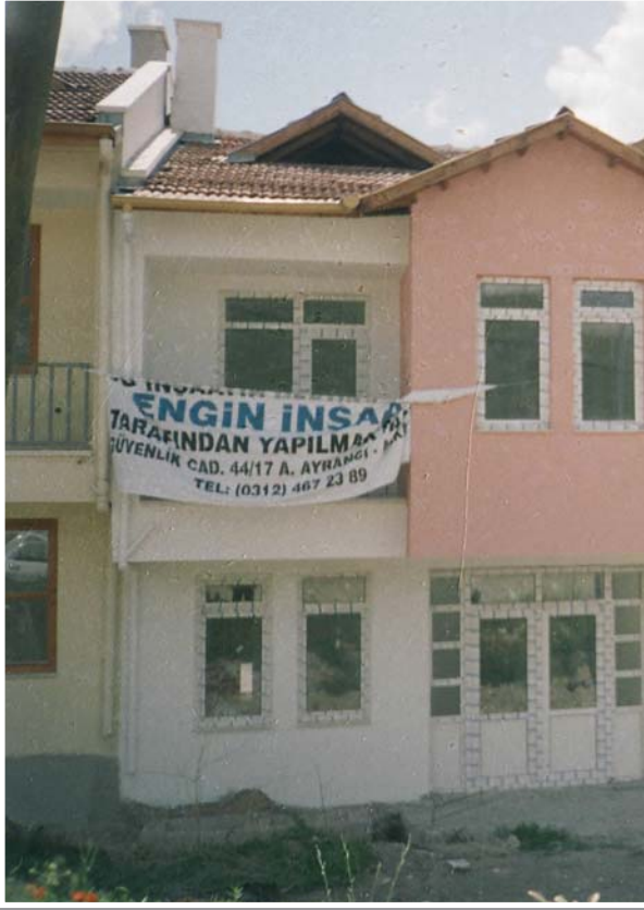
Ankara Ümitköy' de 3 adet villa İnşaatı
