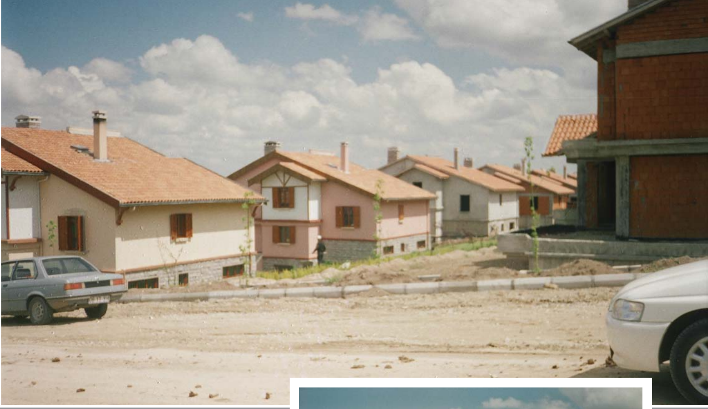
8 adet villanın kaba inşaatı.
