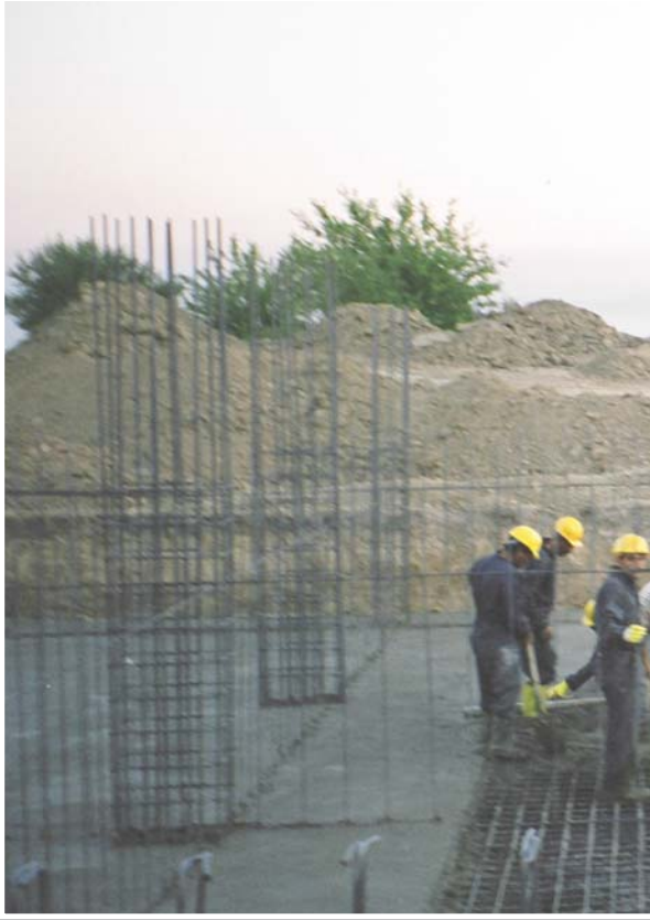
İşletme binası inşaatı.
